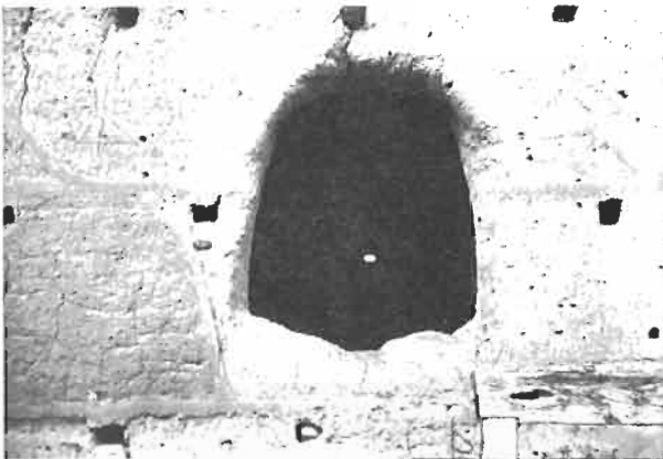
FIGURE 36 : L'OUVERTURE DES FENÊTRES EST SOUVENT TAILLÉE DIRECTEMENT DANS LE MUR SANS LINTEAUX NI MONTANTS.
