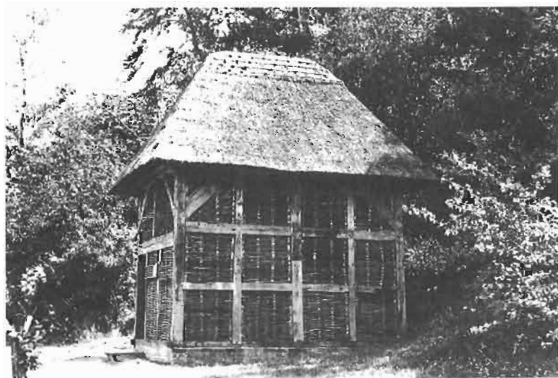
FIGURE 293 : ▶ « CATHERINGTON TREAD WHEEL » XVII e SIÈCLE (MUSÉE EN PLEIN AIR DE SINGLETON) CETTE PETITE MAISON ABRITTE UNE ROUE DANS LAQUELLE MARCHAIT UN HOMME POUR FAIRE REMONTER L'EAU D'UN PUIT. ELLE N'A JAMAIS ÉTÉ ENDUITE DE TERRE, CHOSE COURANTE À L'ÉPOQUE
