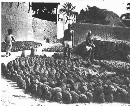
FIGURE 148 : BRIQUES EN FORME DE POIRE (NIGÉRIA)
