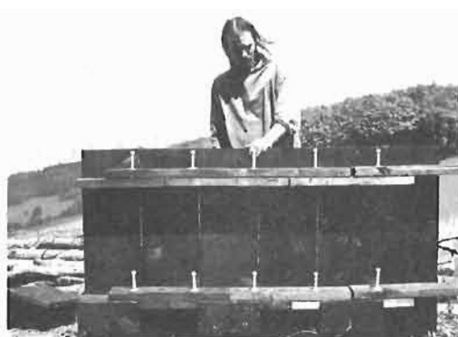
FIGURE 97 : BANCHE ARTICULEE PERMETTANT DES MURS COURBES AINSI QUE DES POTEAUX - POSITION RECTILIGNE (LE PIN, 1975)
