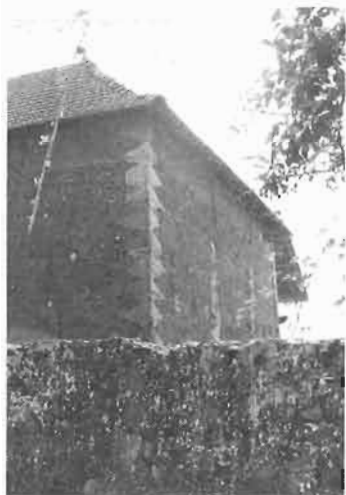
FIGURE 30 : RENFORCEMENT DE L'ANGLE EN « DRAPEAUX » (ISERE)
