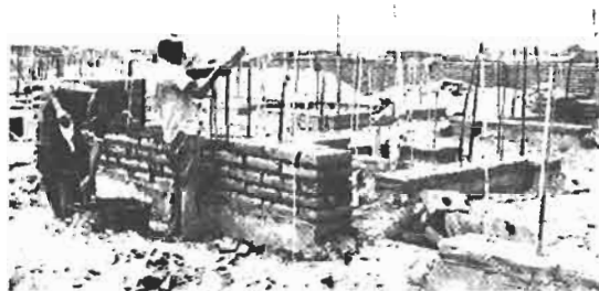
FIGURE 207 : ÉLEVATION DU MUR. LES BRIQUES TROUÉES SONT ENFILÉES SUR LES ROSEAUX.
