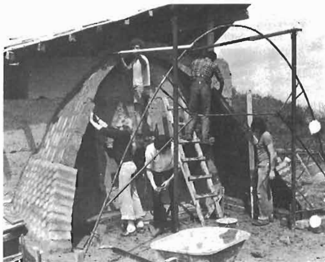
FIGURE 314 : LE MAÇON EN HAUT A GAUCHE VÉRIFIE QUE LE PROFIL DE LA VOUTE RESTE CONSTANT
