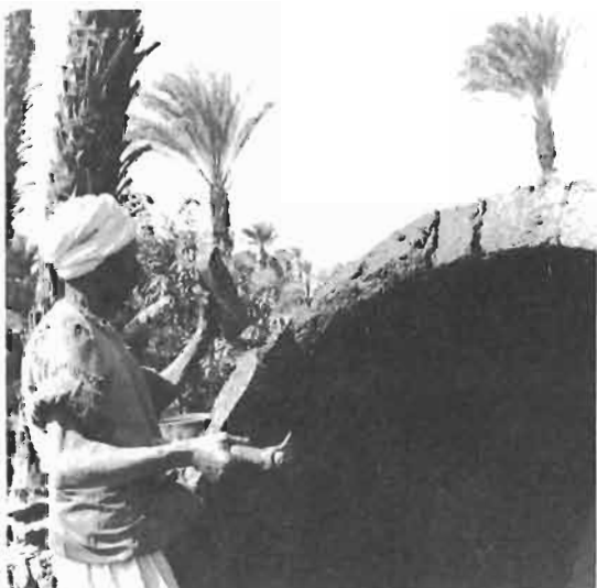
FIGURE 310 : LE MAÇON NUBIEN S'APPRETE A « COLLER » LA BRIQUE SUR LA COUCHE DE MORTIER. ON DISTINGUE SUR UNE FACE DE LA BRIQUE LES SILLONS, CREUSES AU MOULAGE, ET QUI AMELIORENT L'ADHERENCE DE LA BRIQUE AU MORTIER
