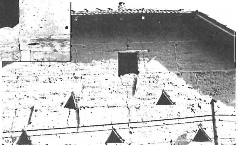
FIGURE 36 : L'OUVERTURE DES FENÊTRES EST SOUVENT TAILLÉE DIRECTEMENT DANS LE MUR SANS LINTEAUX NI MONTANTS.
